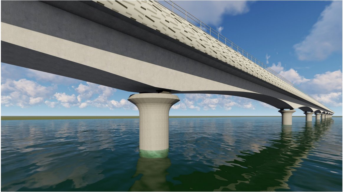
Esquisse architecturale du nouveau pont du Larivot avec un tablier de hauteur variable
