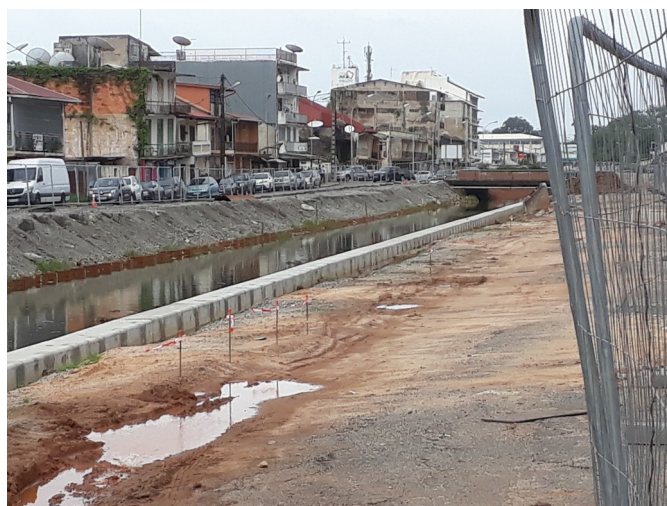
Chantier du Canal Laussat – Cayenne
